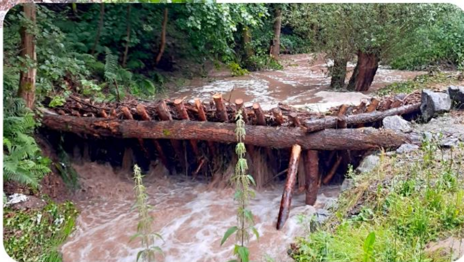
Rechen Weißbach vor Ortslage Unterweißbach Rechenkonstruktion aus Holz
