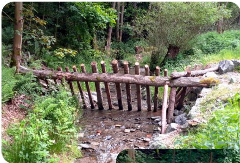
Rechen Weißbach vor Ortslage Unterweißbach Rechenkonstruktion aus Holz
